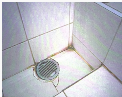
ภาพ ระบบดักกลิ่นที่ท่อรับน้ำทิ้งที่พื้นห้องส้วมชำรุด
